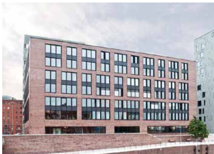
📍 The office building of RHL at Brooktorkai | Das Bürogebäude der RHL am Brooktorkai
